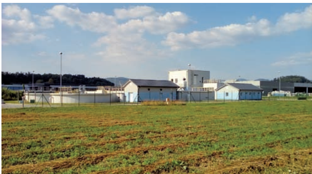
Nová ČOV v Krupine je vybavená modernými technológiami.
