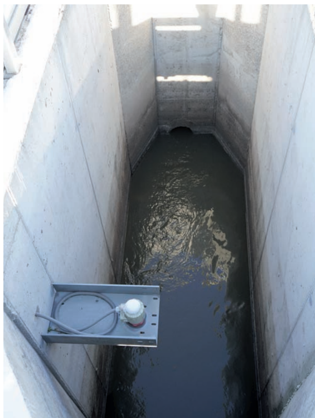
Ultrazvukové meranie prietoku v otvorenom žľabe
