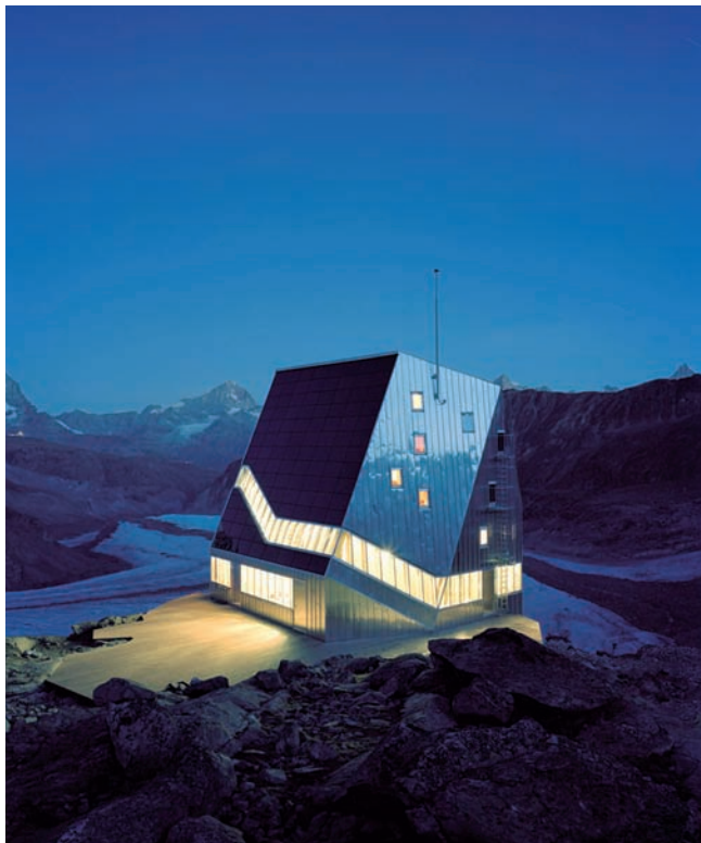
Riadenie spotreby energií, tepelného a klimatického komfortu na základe zohľadnenia aktuálneho počasia je v horskej chate Monte Rosa realitou.
