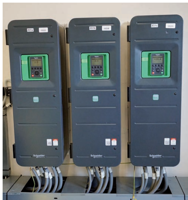
Frekvenčné meniče plynulo riadia otáčky dúchadiel na základe merania koncentrácie rozpusteného kyslíka v aktivácii pomocou kyslíkovej sondy.
